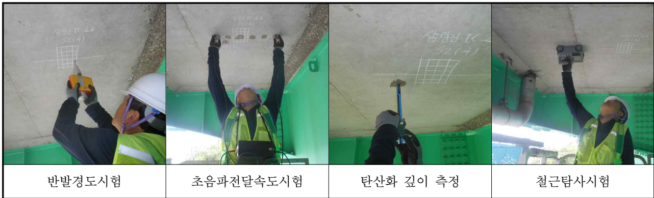
【사진 3.3.1】 콘크리트 내구성조사 전경
