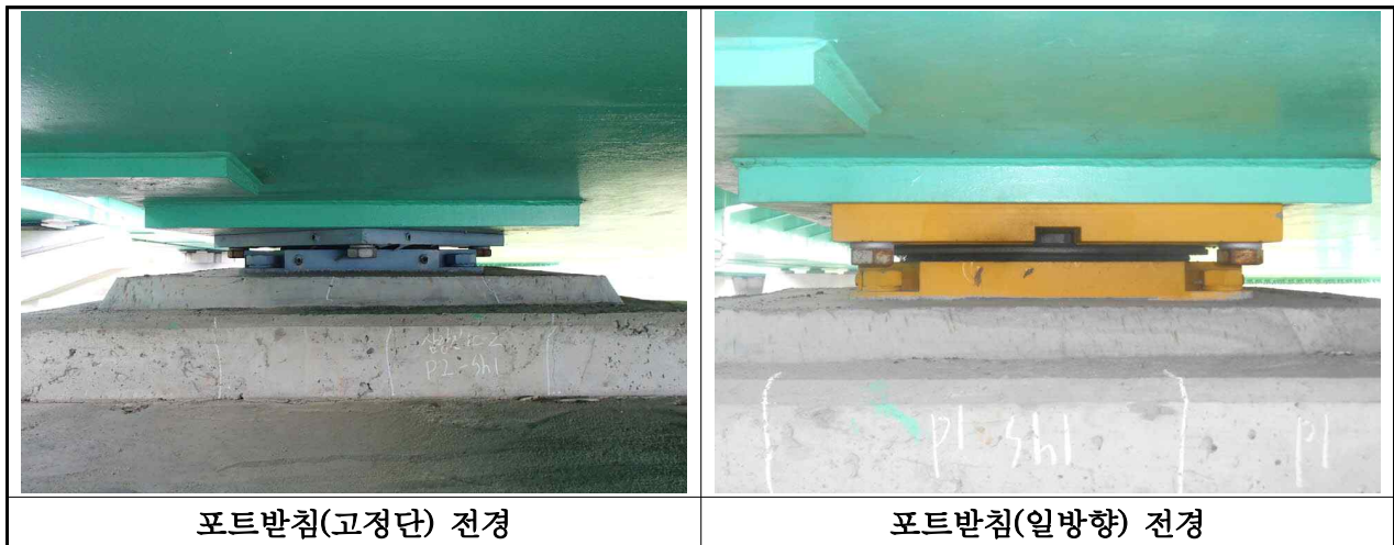
【사진 3.2.11】 교량받침 전경
