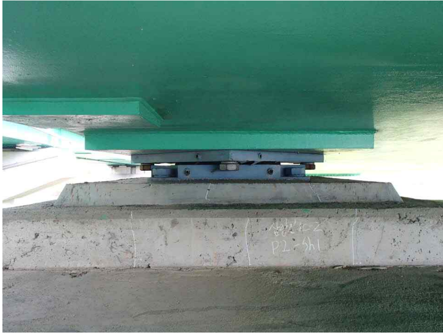
받침장치 전경 (고정단)
