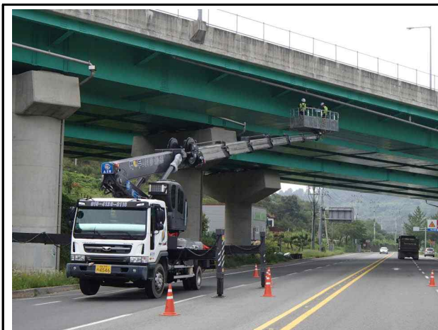
교량점검차를 이용한 조사
