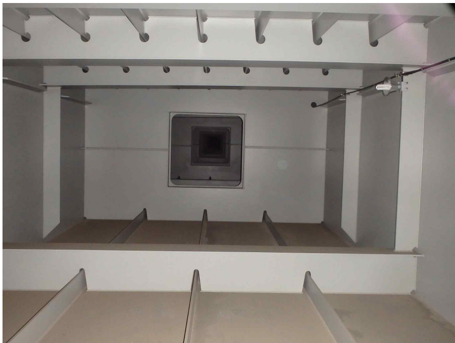
Steel Box Girder 내부 전경
