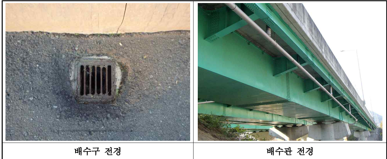
【사진 3.2.18】 배수구 및 배수관 전경
