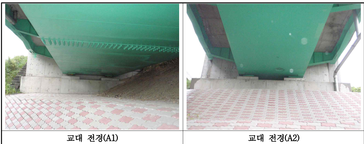
【사진 3.2.7】 교대 전경
