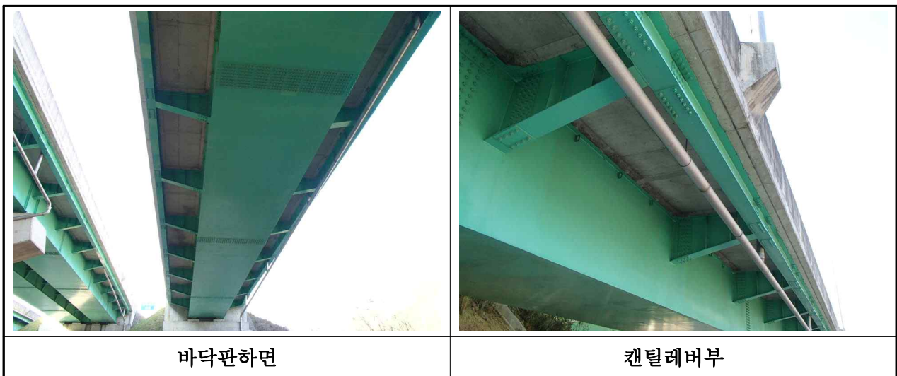
【사진 3.2.1】 바닥판 전경
