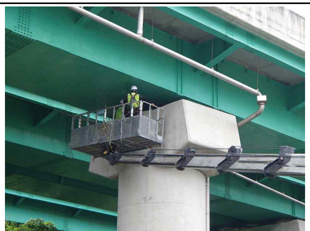
고소점검차를 이용한 조사
