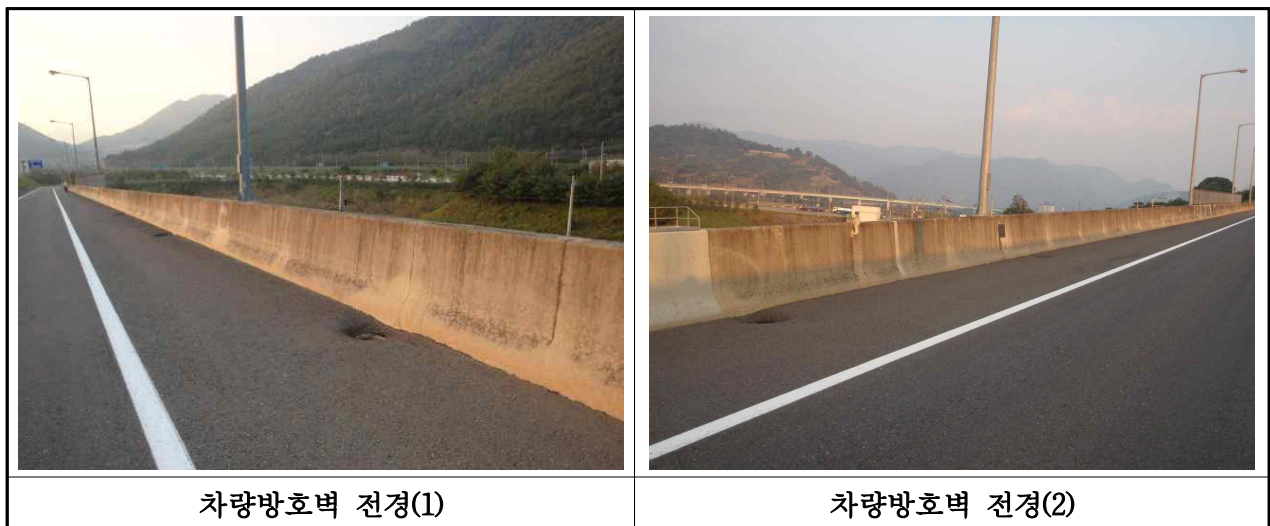
【사진 3.2.19】 방호벽 전경
