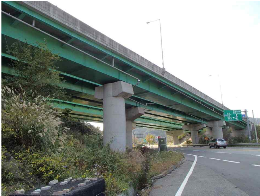
Steel Box Girder 외부 전경
