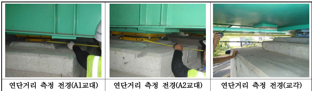
【사진 3.2.13】 연단거리 측정 전경
